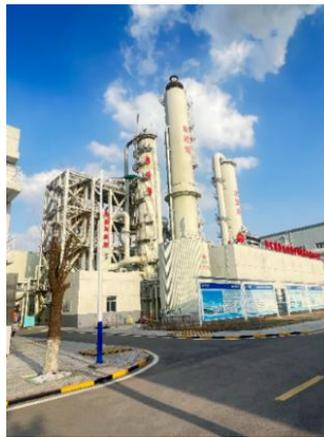
中国神华组建了一支跨学科研发团队，致力于推动碳捕集技术的创新与产业化应用。在技术研发方面，中国神华通过创新性地集成“级间冷却+分流解吸+MVR闪蒸”节能新工艺，并成功开发出新型复合胺吸附剂、低成本塑料填料和高效超重力反应器等核心装备，使整体捕集效率提升30%的同时降低能耗25%。2021年，中国神华建成“15万吨/年燃烧后CO<sub>2</sub>捕集示范项目”，不仅验证了技术可行性，更为后续规模化应用奠定了坚实基础。目前，该技术已在多个燃煤电厂及化工、水泥等高排放行业成功推广应用。
